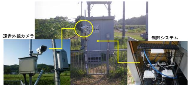
図-10 局舎\_観測システム外観（幾春別川藤松）
