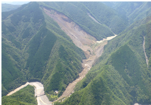
図-1 平成23年台風12号によって発生した深層崩壊
