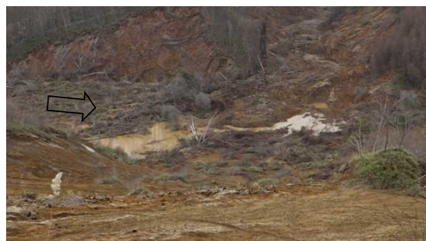
写真-3 谷底平野部の堆積土砂と湛水
