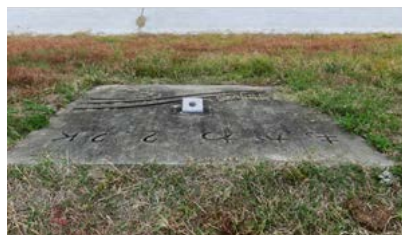
図-2 Z地点の法面の状況
