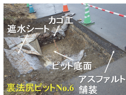
図-3 裏法尻の調査ピット (No. 6) の様子
