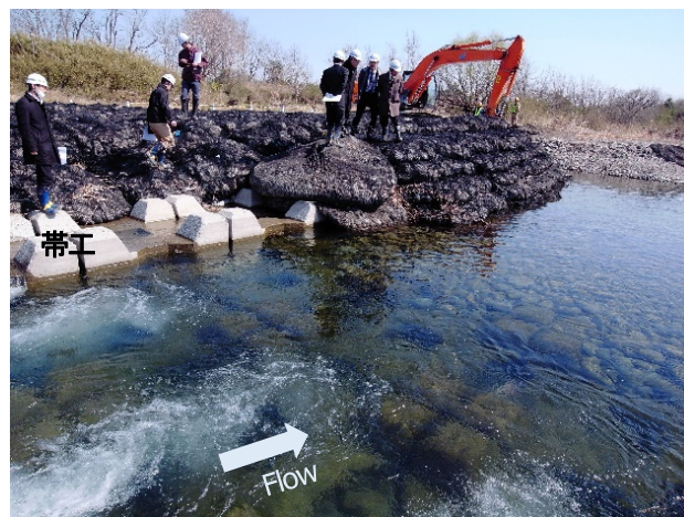
図-15 新たに設置した帯工袖部の袋詰玉石工の全景
