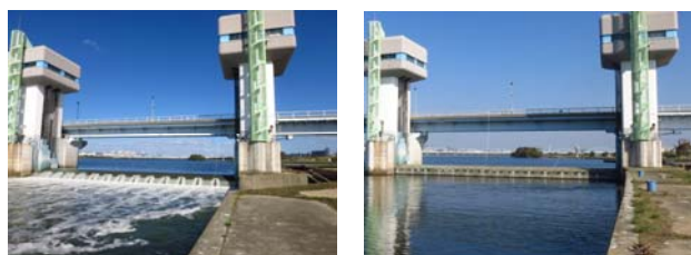
図-12 淀川大堰調節ゲートの越流・閉塞状況
