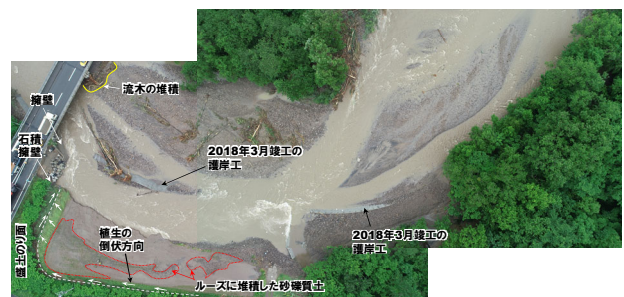
図-5 被災後の状況（ドローンによる空撮）
