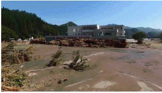
写真-1 2016年台風10号による岩手県岩泉町での小本川水系小本川氾濫被害（国土地理院撮影）
