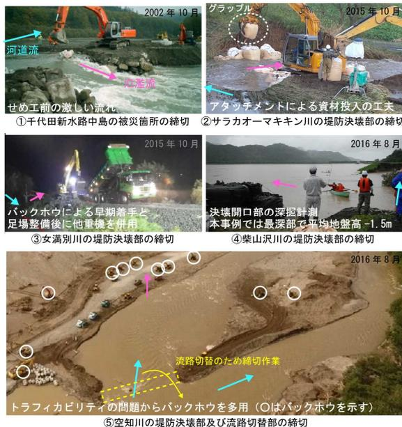
図-1 北海道内における堤防決壊時の緊急対応工事の一例
