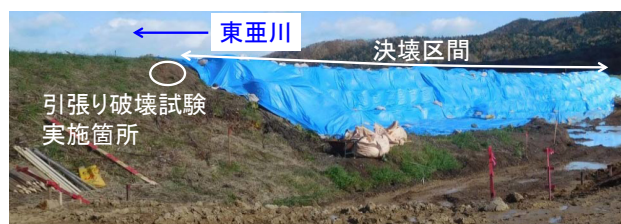
図-9 引張り破壊試験実施箇所及び実施状況
