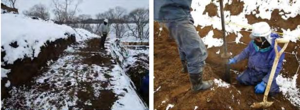
図-11 ニツ森川被災箇所の開削断面と試料採取の状況
