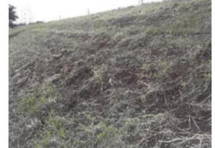
(c) 堤防表法表土抜け出し
