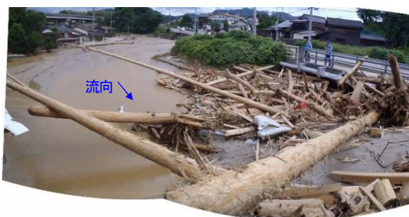
写真-4 前田橋閉塞状況（区間III）（8月10日撮影）
