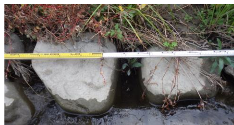
写真-2 大型張りブロックの水際域（タイプ）
