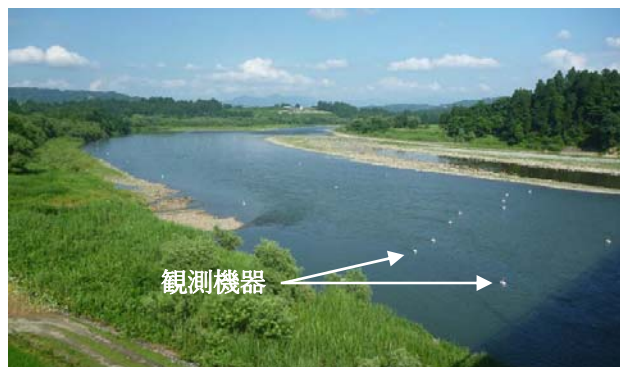
図-3 観測機器設置状況例（川井大橋地区）
