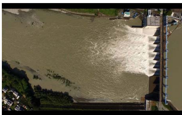
写真-5 474m 3 /s放流時の流況（UAV, 高度250m）
