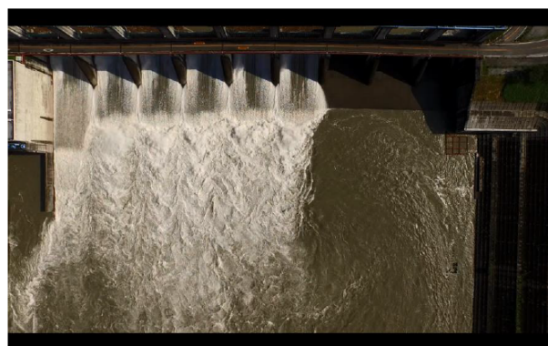
写真-6 474m 3 /s放流時の流況（UAV, 高度150m）
