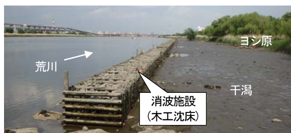
図-1 木工沈床による消波施設(千住桜木地区：干潮時)
