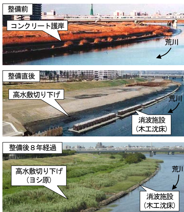
図-5 小松川地区の整備前後の状況
