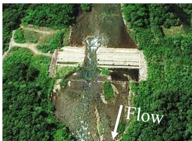
図-4 戸蔭別川第5号床固工
