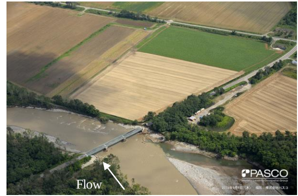
図-6 河岸浸食に伴う中島橋右岸における橋梁背面盛土の浸食(撮影；株式会社PASCO)
