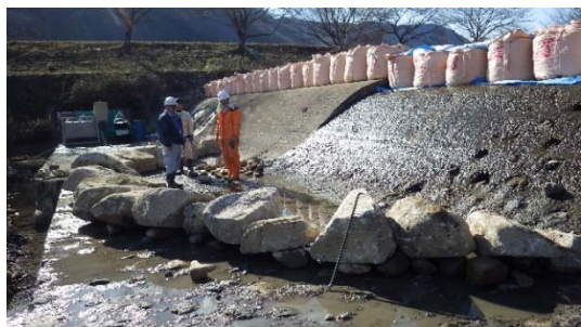
写真-8 頭首工に巨礫を1層目に設置した状態
