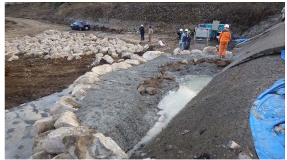
写真-11 堰堤からの漏水を排水しながら施工している状態
