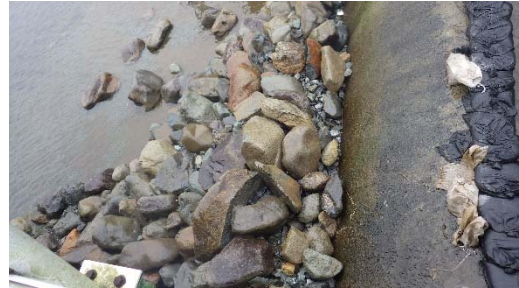
写真-20 10月6日の出水後の未完成段階の石組みの状態
