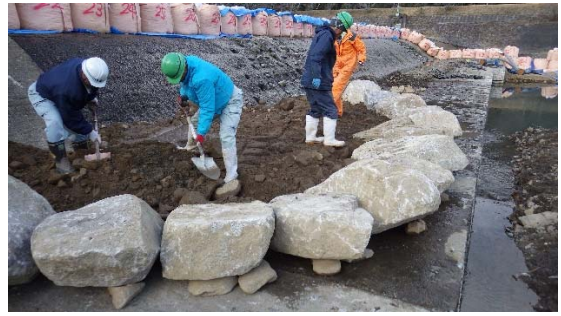
写真-9 巨礫の背後に河道整備で発生したグリ・碎石が混在する土砂で埋設した状態
