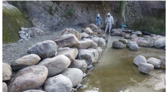
写真-5 原型規模の石組みの状態
