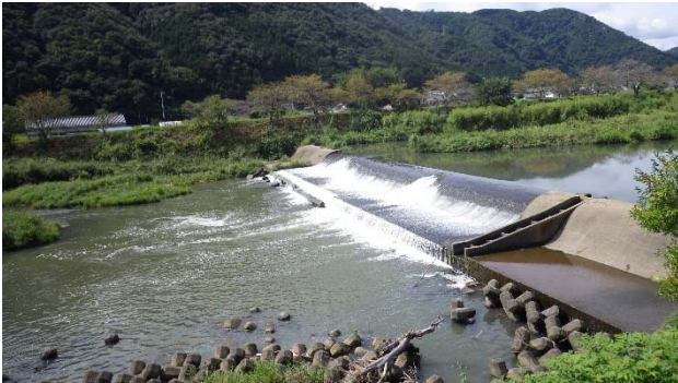
写真-2 岡山市内を流れる宇甘川における頭首工（中泉堰）
