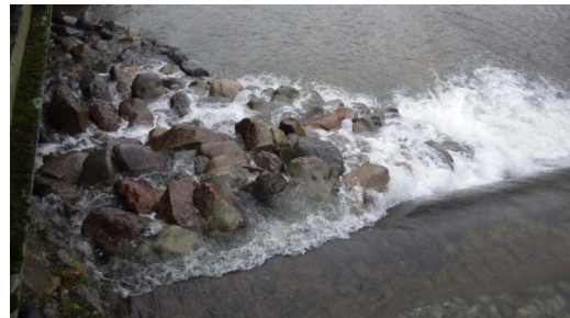
写真-21 越流水深10cm前後の流況その1（2017. 10. 15記録）
