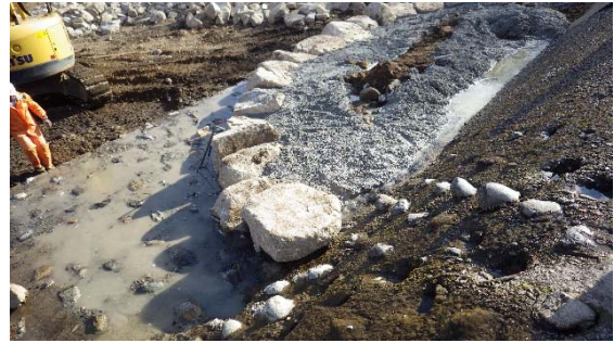
写真-10 生コンクリートを10cm程度打設した状態
