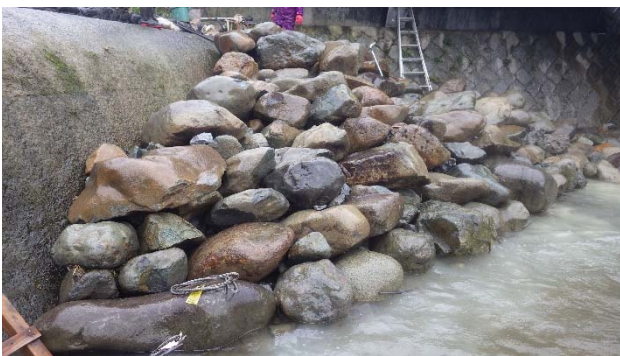
写真-18 空積み石組みが組みあがった状態（2017. 10. 15記録）
