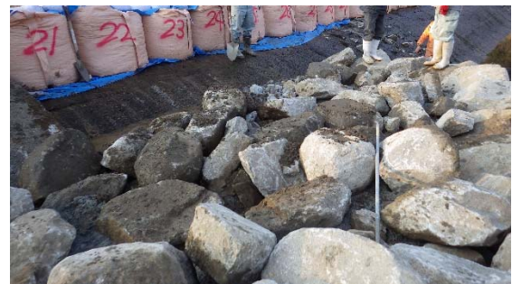
写真-13 堰堤天端近くの施工処理の状態
