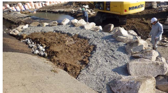
写真-12 堰堤の越流面との境界近くの施工処理の状態
