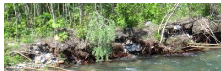
写真-2 高水敷上に繁茂するヤナギ (札内川上流部)
