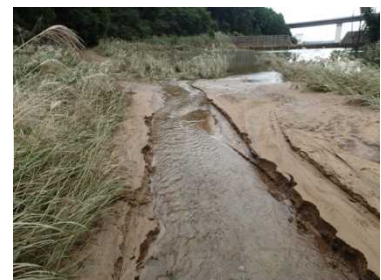
写真-3 平成29年10月現在の下流堰堤堆砂状況
