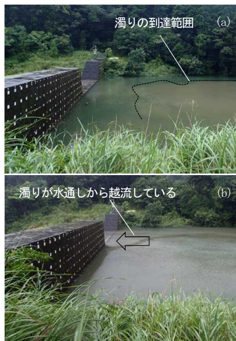
写真-4 堰堤での濁り滞留状況 (a)越流前 2017/8/7 11:47 (b)越流後 2017/8/7 12:09
