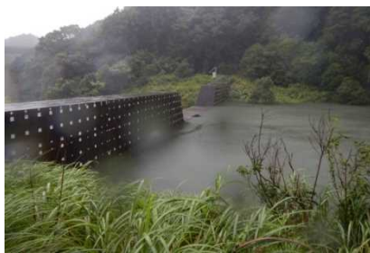
写真-1 出水時の下流堰堤湛水状況
