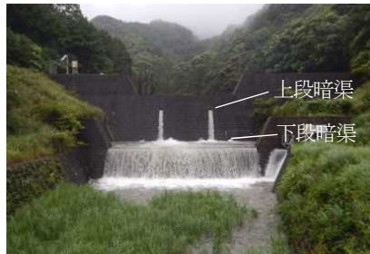
写真-2 出水時の上段暗渠からの排水状況
