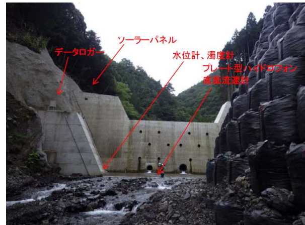
図-2 観測箇所および機器設置状況
