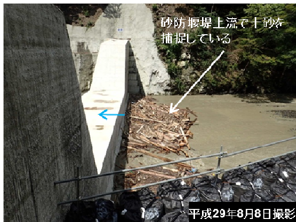
写真-1 台風5号後の観測箇所直上流砂防堰堤
