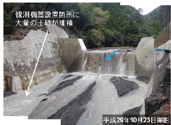
写真-2 台風21号後の観測箇所直上流砂防堰堤
