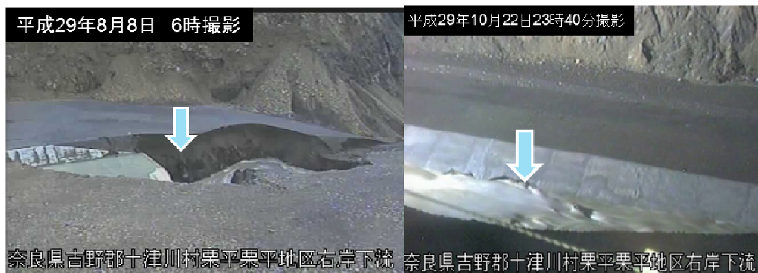
矢印は侵食箇所を示す。なお、カメラの方向は異なる方向を映している。
