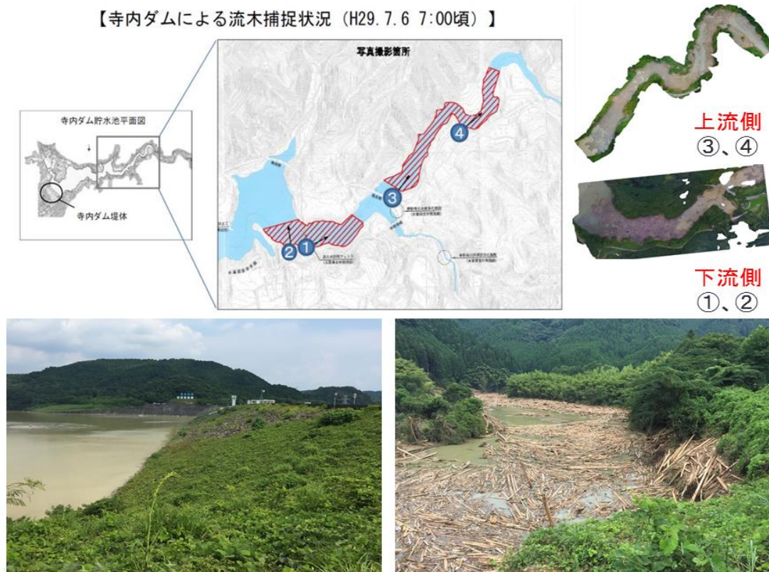
図-1 寺内ダムにおける流木の集積状況（上：集積範囲，下左：貯水池下流，下右：貯水池上流）
