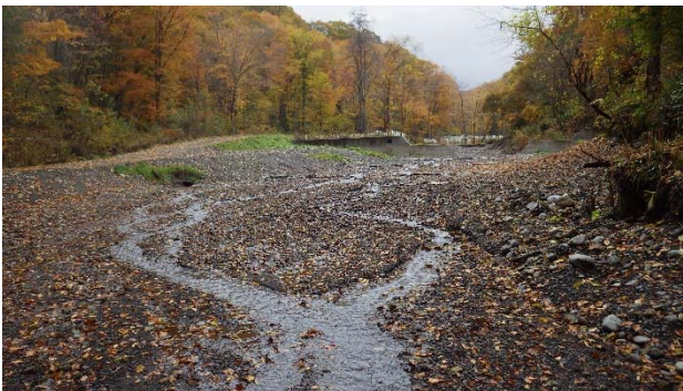
写真-15 写真11の下流側の状態 (2016年10月)
