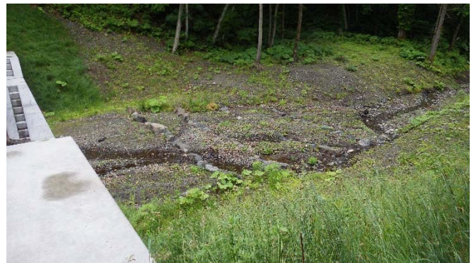
写真-11 施工後2年目の状態 (6月)
