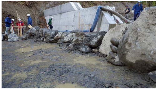
(a) 掘り込み型減勢池下流端を兼ねた石組みの施工
