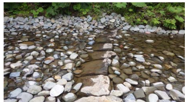
(b) 施工された石組み帯工（帯工幅 10~13 m）
