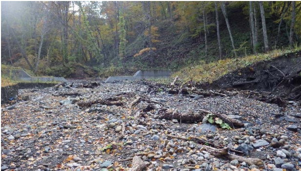
写真-13 写真11の上流側の状態 (2016年10月)
