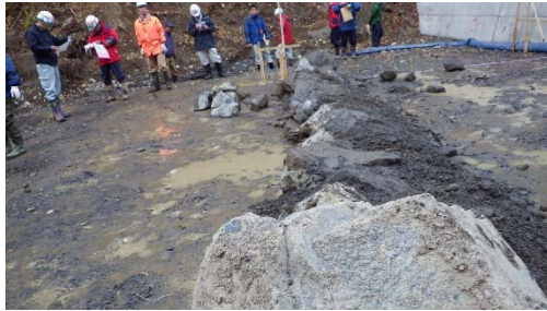
(b) 巨礫で石組みした上流面を間詰めした状態
