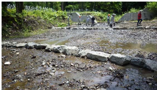
(c) 石組み帯工間を間詰め施工した状態
