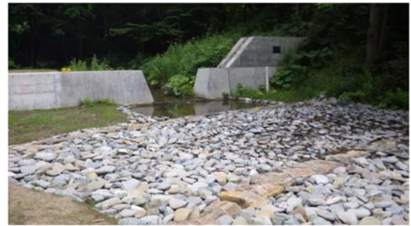
(a) 施工された掘り込み型減勢工（スリット幅 2.5m）
