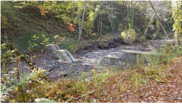
写真-12 施工後3年目の状態 (2016年10月)
