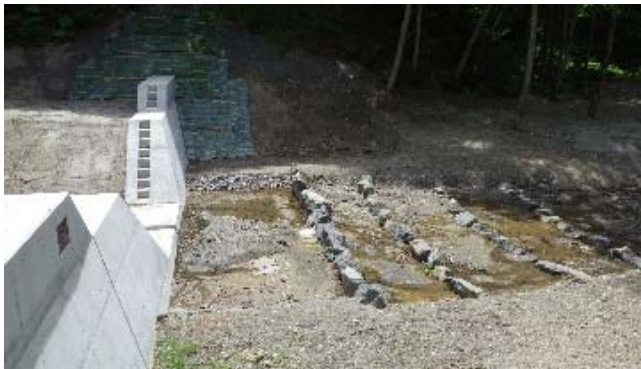
写真-8 堰堤下流側の石組みの施工状態
