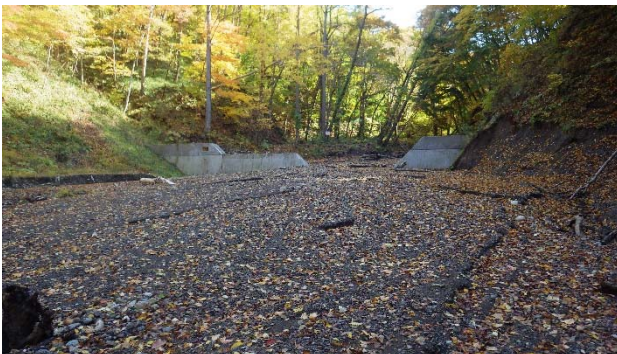
写真-14 写真11の上流側（最上流堰堤）の状態 (2016年10月)
