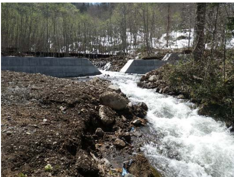
写真-2 河道を狭めたことによって河床低下した事例
