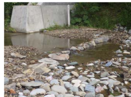
(b) 施工された石組み帯工（帯工幅 10~13 m）
