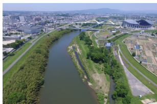
図-1 白浜工区全景
