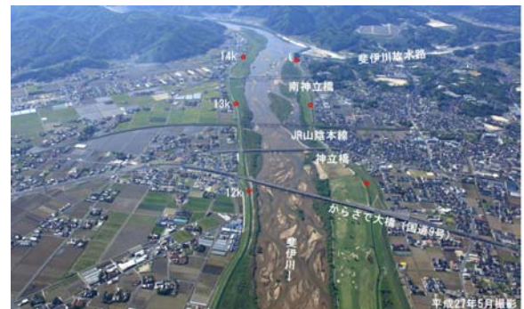
写真-1 平水時の斐伊川下流部
