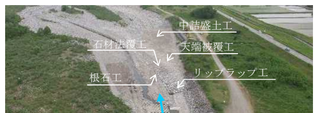
図-1 「巨石付き盛土砂州を用いた河岸防護工」の機能
