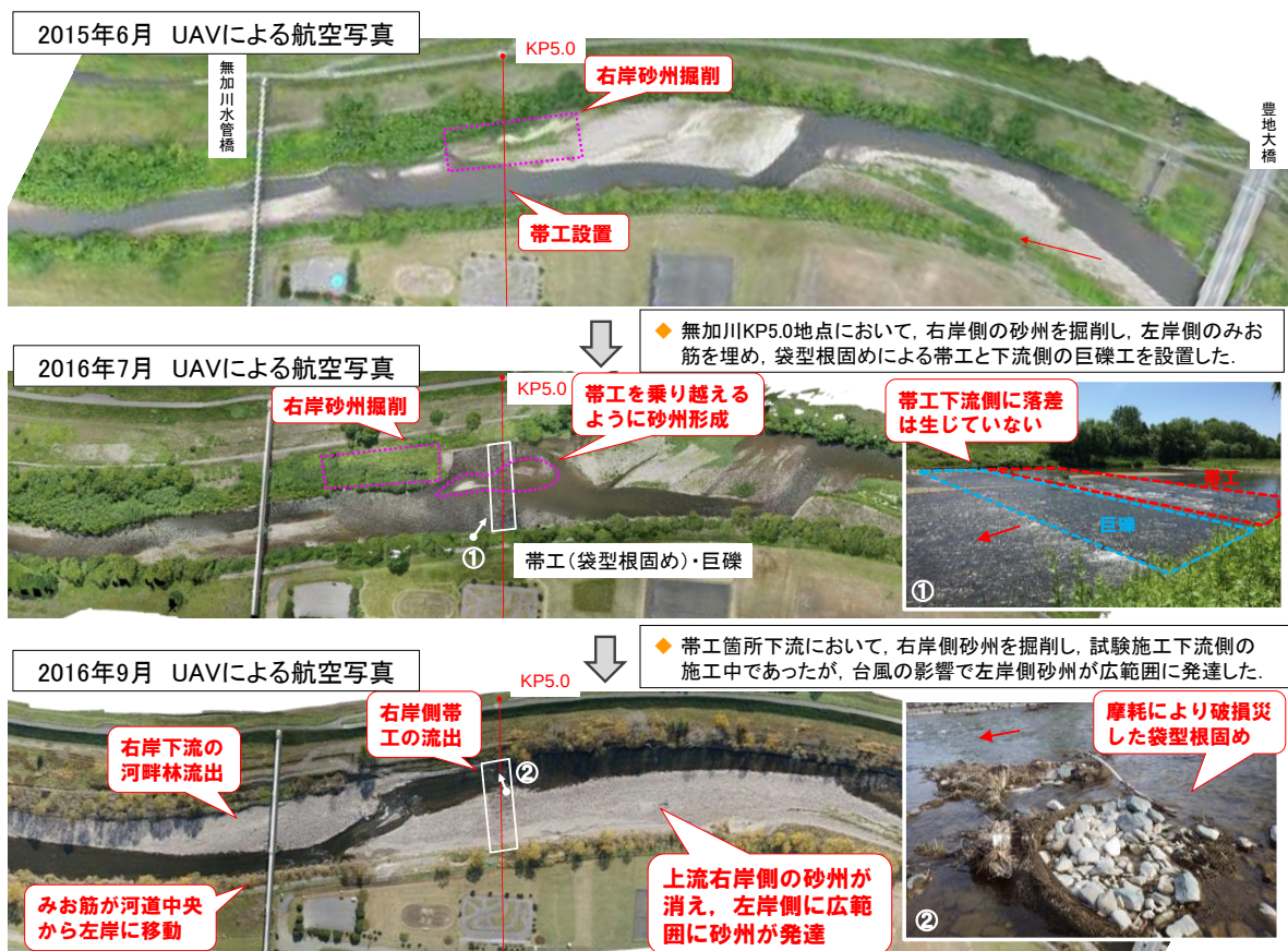
図-7 試験施工箇所周辺の河道変化
