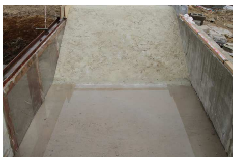
写真-1 130分の川裏法尻の状況 (ケース1)
