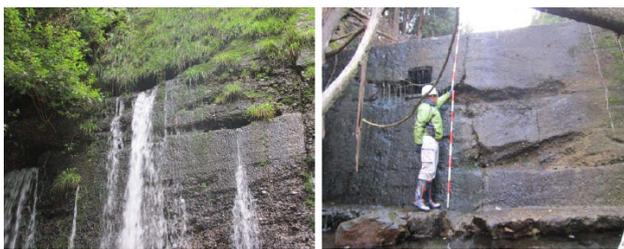
図-5 コンクリート砂防堰堤における剥離欠損の変状事例
