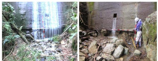
図-7 コンクリート砂防堰堤における洗掘(基礎)の変状事例
