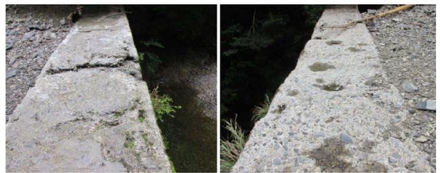
図-1 コンクリート砂防堰堤における天端摩耗の変状事例
