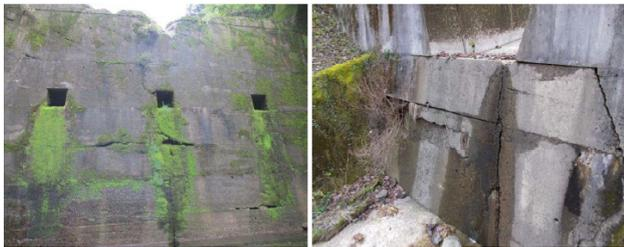
図-3 コンクリート砂防堰堤におけるひび割れの変状事例
