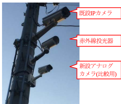
図-8 設置カメラ(新構)
