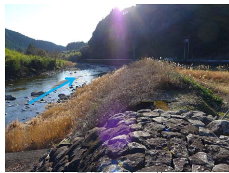
a) 霞堤開口部の状況
