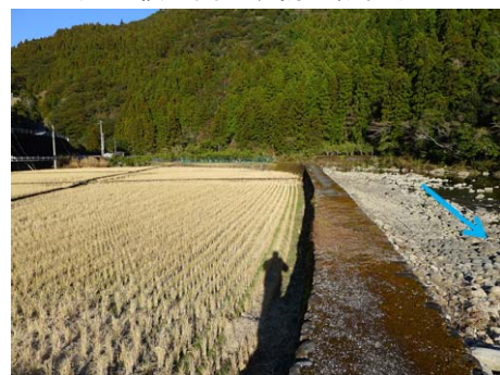
c) 練積区間の堤防の設置状況
