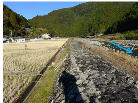
b) 空積区間の堤防の設置状況
