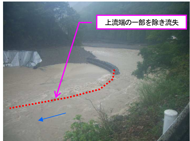
図-13 台風11号による増水（8/9 8:30）
