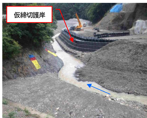
図-1 仮締切護岸状況（平成26年10月）
