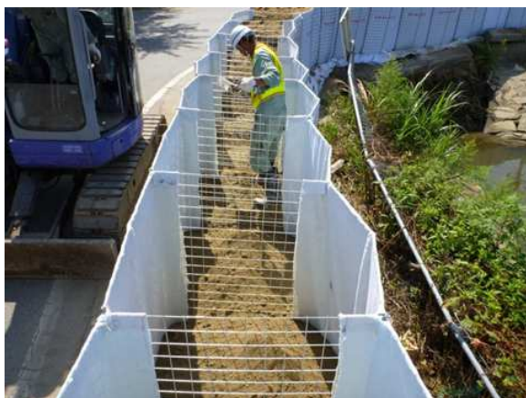
図-3 展開後の中詰め材充填状況
