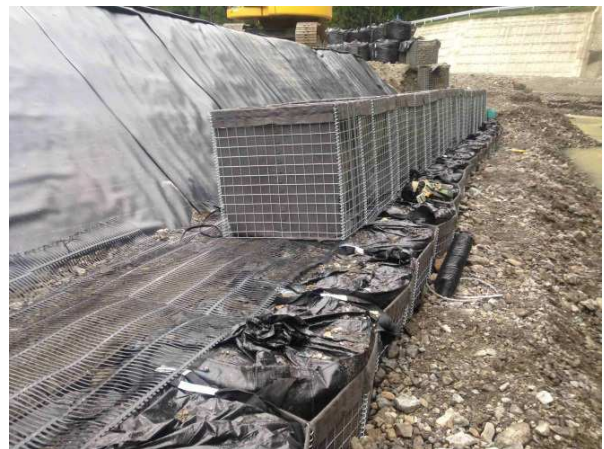
図-19 仮締切護岸補強対策実施状況
