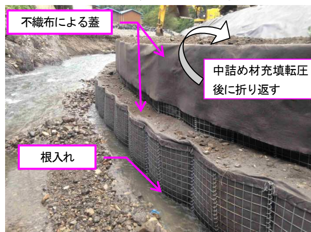
図-10 仮締切護岸施工状況（当初）
