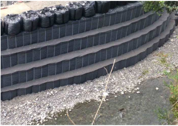
図-11 仮締切護岸設置状況（当初）
