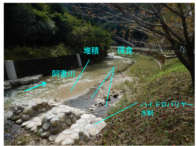
写真-5 ハイドロバリアー水制施工後の状況 (2016年10月12日撮影)
