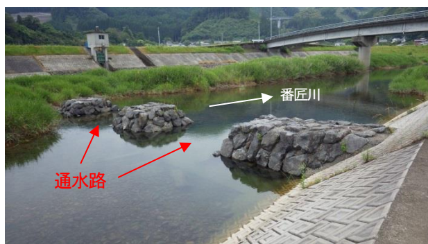
写真-1 胸部に通水路を持つハイドロバリアー水制 (番匠川水系久留須川水口地区 2015年5月18日撮影)
