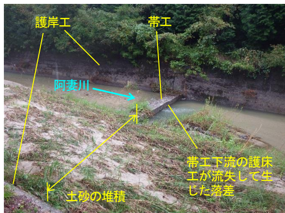
写真-2 河床横断形状の二極化の状況（施工前） (2013年10月15日撮影)
