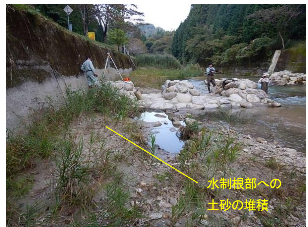
写真-6 ハイドロバリアー水制下流の状況 (2016年10月12日撮影)
