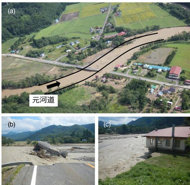
図-1 千呂露橋被災状況(aは北海道開発局提供)
