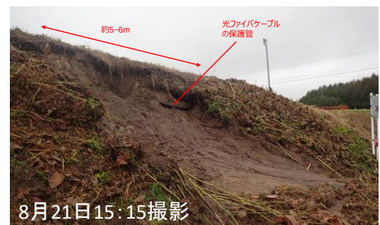
図-15 奔隈川左岸堤防裏法の法崩れの状況
