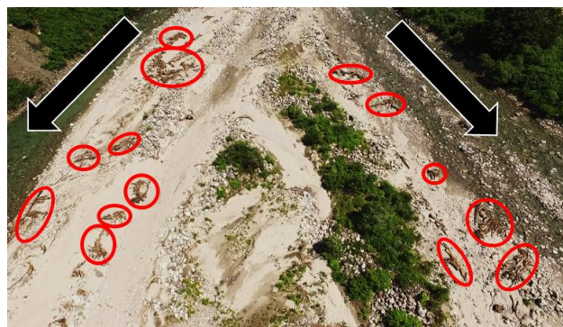
図-7 山間域における中洲の空撮画像(18.2 kp付近)
