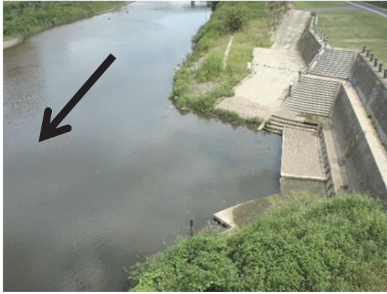
図-1 研究対象施設(平成26年7月1日)
