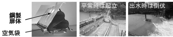
図-5 仮設ゲート(SR堰)の概要
