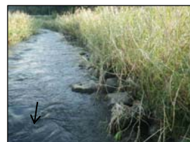
①空石積護岸:串良川 8k900 付近 ②捨石:始良川 6k200 付近
