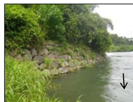
①空石積護岸:串良川 8k900 付近 ②捨石:始良川 6k200 付近
