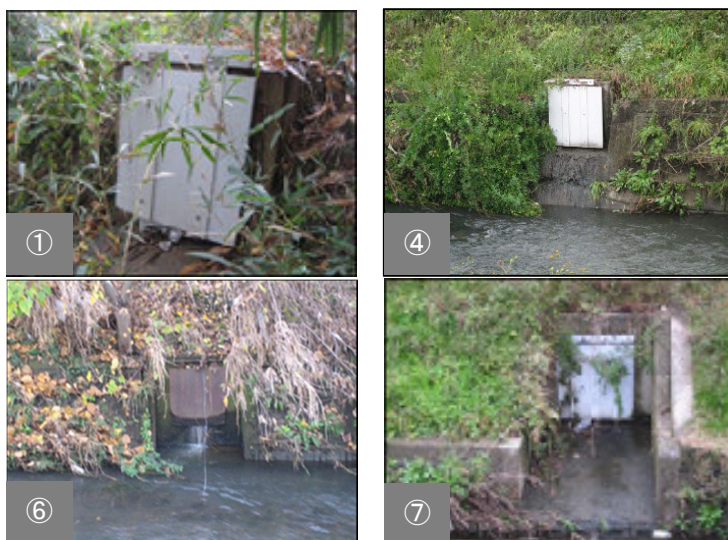
写真-1 豊徳川の雨水排水口の例(番号は図-4に対応) 6)
