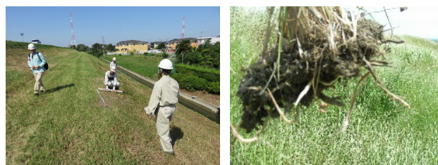
図-1 堤防点検及び根張りの乏しいセイバンモロコシの状況
