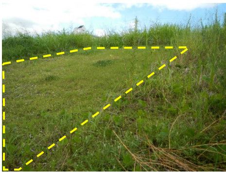
図-12 イワダレソウ（細断茎の散布）で被覆した川裏側堤防法面
