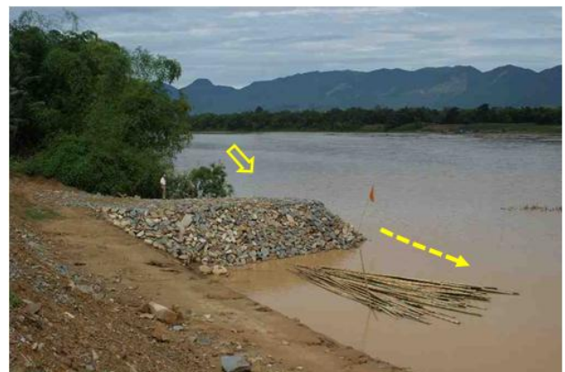
写真-5 Thanh Xuyenの石積み水制工 (2010)
