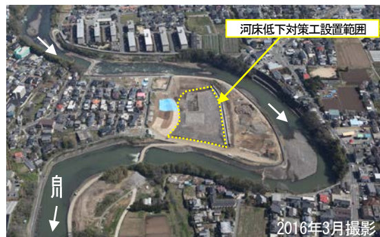
写真-4 現地施工の様子
