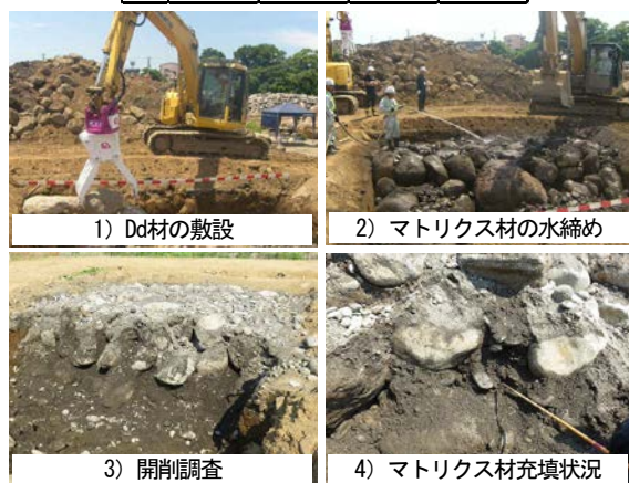
写真-3 試験施工写真
