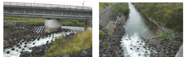
写真-2 下鑑別橋の護床工（2013年撮影）
