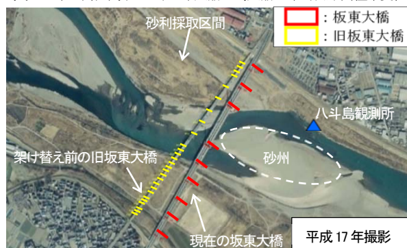
図-7 新旧坂東大橋の橋脚と砂利採取位置(H17 撮影)
