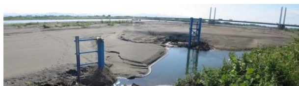
図-2 平成 23 年台風 15 号の土砂堆積状況
