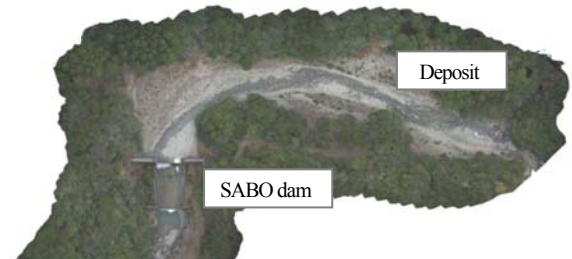
図-11 ドローン空撮機による砂防堰堤の堆砂状況把握の一例
