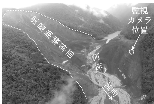
写真-1 赤谷地区深層崩壊斜面とビデオカメラの位置
