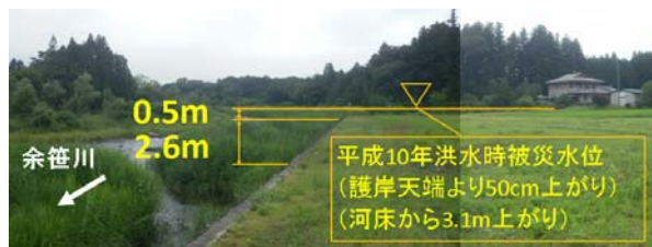
写真-1 余笹川19.5km左岸の平成10年洪水の痕跡(聞き取りより)
